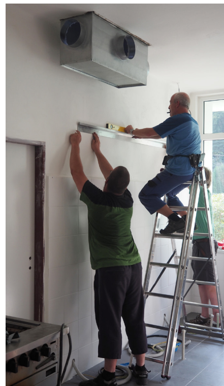
» Práce v mateřské škole jsou v plném proudu, instalace vzduchotechniky ve školní kuchyni.
